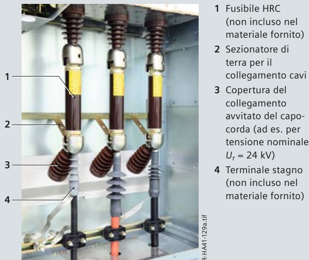
Fusibili HRC nell'unità trasformatore tipo T vista laterale
