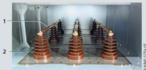
Cella sbarre su 3 unità (esempio ≤ 17,5 kV) vista laterale
